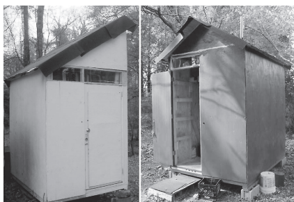
Fig.8 Mad Housers Shelter (Hut). 都市の中に廃材で小屋をつくり、ホームレスが生活できるようにするプロジェクト "Mad Housers Shelter (Hut)." A project to build free shelters using waste materials for homeless people.
