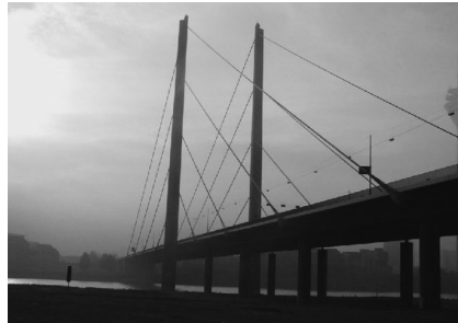
Fig.6 Knie橋、斜張橋のさきがけとなったライン川橋梁群のひとつ Knie Bridge, one of the early cable-stayed bridges built over the Rhine
