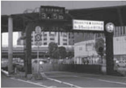
Fig.1 トンネルの高さ制限表示。同じ表示が5つもある。(日比谷 東京)
