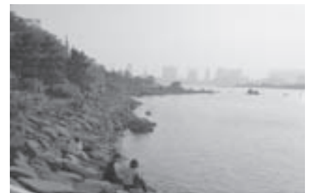
お台場 自然型護岸 設計/(株)東京ランドスケープ研究所 Natural-type embankment, Odaiba (Tokyo Landscape Architects, inc.)
