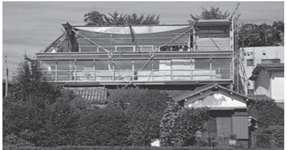
現在建設中の自邸「世田谷村」
