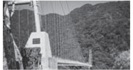
照葉大吊橋／照葉樹林帯にかかる世界一の歩く吊橋（宮崎県綾町） The huge Suspension Bridge for a walk at Aya Town, Miyazaki-pref.
