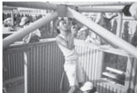
ボランティアによる「紙のログハウス」建設風景
