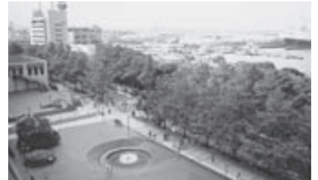
山下公園前面街区の街づくり 広い歩行空間と敷地内広場(ピア広場)
